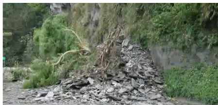
蘇花武塔段土石大坍方 阻斷雙向道路 2016-05-30 13:58 聯合報 記者吳佩旻／即時報導
